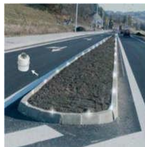
KYKLOP PRG.1 montáž do obrubníka
